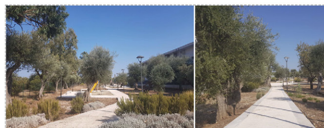
Realizzazione di pavimentazione ciclopedonale ecocompatibile in terra stabilizzata presso il Parco Gentile di Bari . [https://www.terrasolida.it/]
