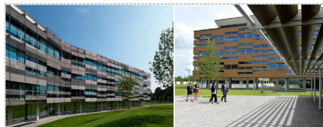
Realizzazione delle pavimentazioni esterne con Betonella® FUTURA per l'ampliamento dell'Headquarter Banca Crédit-Agricole (Parma). [https://www.betonella.it/]
